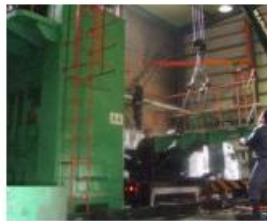
移設、整備、改造
